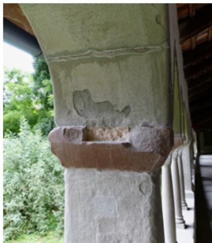
Lose Schichten der Fensterbögen werden entfernt und grössere Fehlstellen aufgefüllt.
