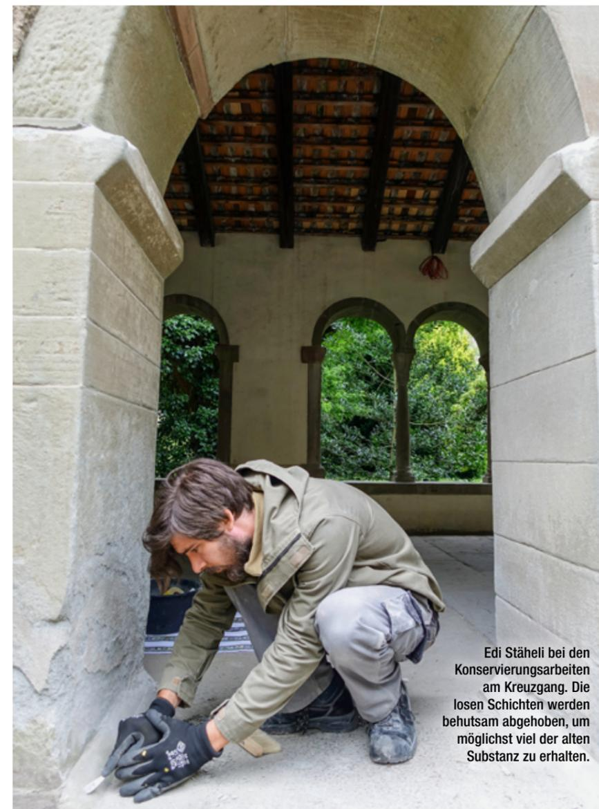
Edi Stäheli bei den Konservierungsarbeiten am Kreuzgang. Die losen Schichten werden behutsam abgehoben, um möglichst viel der alten Substanz zu erhalten.
