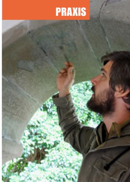
Der Stein ist weich und platzt ab. Mit Kieselsäure-ethylester wird anschliessend verfestigt.
